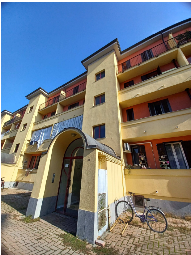
Foto esterna dell'edificio
